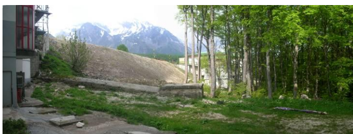
L'area del parcheggio multipiano da valle
