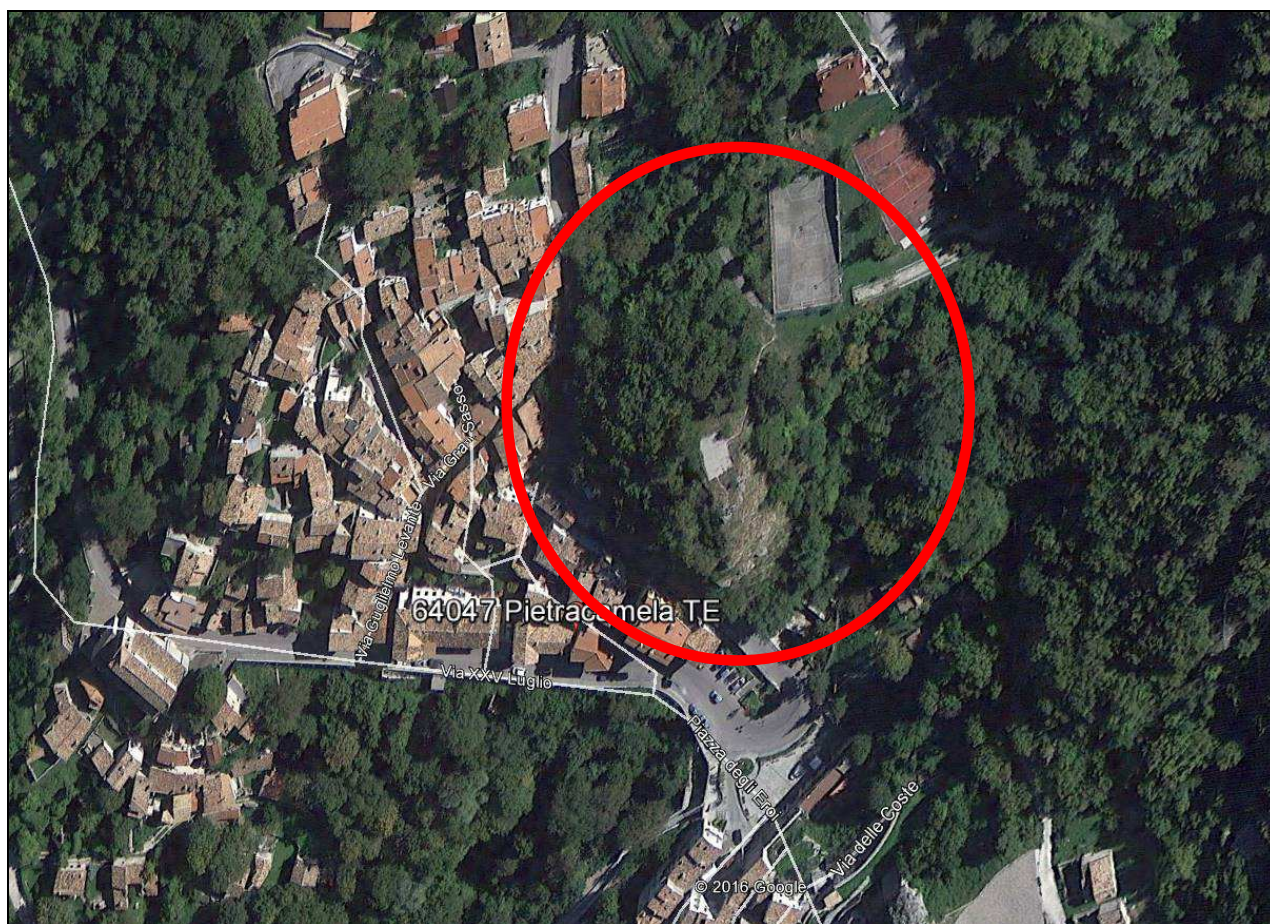
Particolare dell'area di intervento
