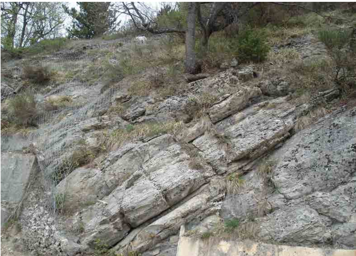
Fig. 20 - Colle Piano. Zona di confine tra le litofacies marnoso-calcarenitica (CRRa) e calcarenitico-calciruditica (CRRb) delle Marne con cerroghna , con J_v < 10 .
