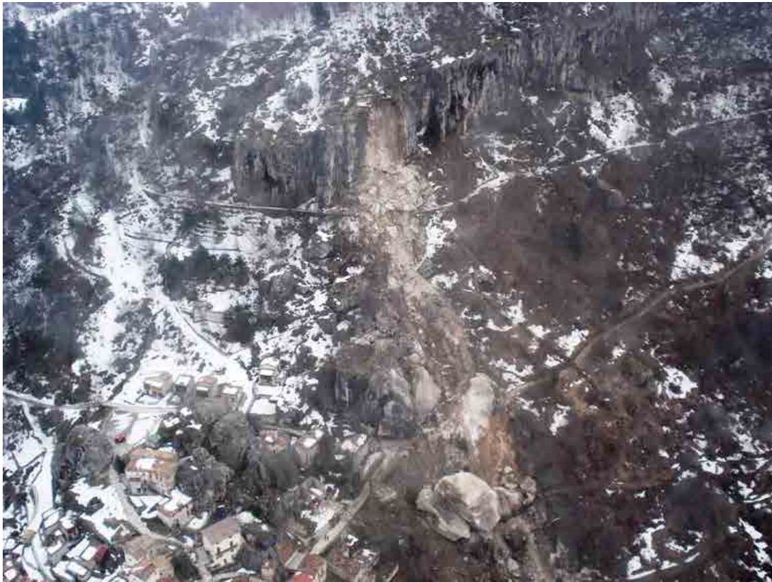
Fig. 8 - La frana di crollo di Capo le Vene del marzo 2011 che ha lambito l'abitato di Pietracamela.
